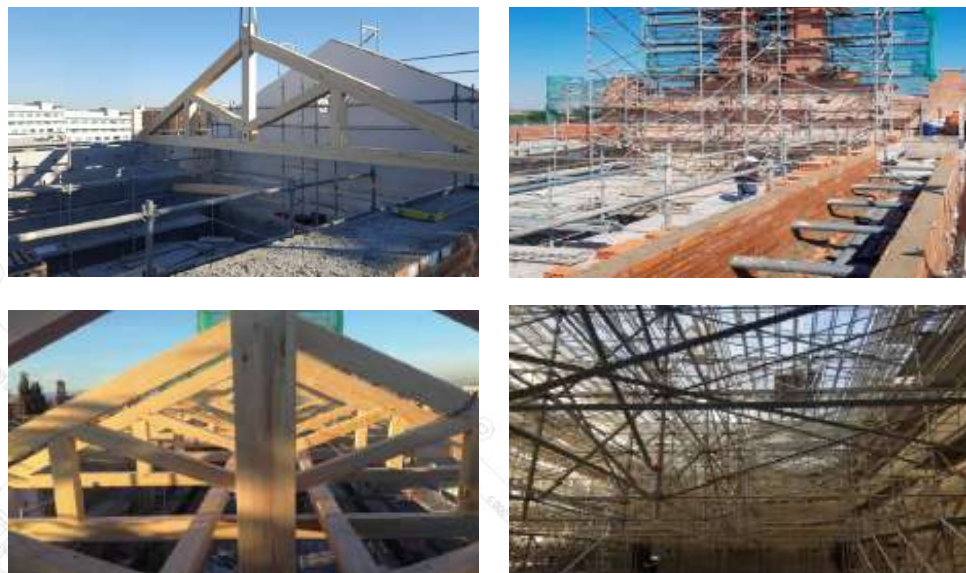
Cubierta de la Iglesia en construcción
